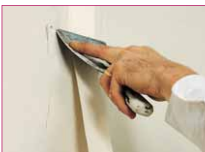
Aplique a fita com a marca Placo voltada para a massa, sobre o eixo da junta.
