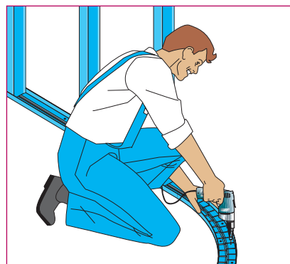
Fixação das cantoneiras já curvadas
