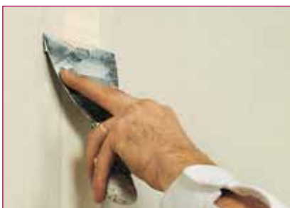
Comprima a fita sem exagero a fim de evitar a saída total da massa. Uma falha de massa pode causar uma colagem defeituosa da fita e uma bolha.
