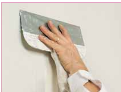
Recobrimento da fita (2ª camada de colagem), passe ao mesmo tempo a massa sobre as cabeças dos parafusos. Após a secagem da 1ª camada, recubra a junta com uma 2ª camada de acabamento mais larga, 2 a 5 cm do que o rebaixo. Esta camada deve ficar com a aparência de trabalho acabado. Passe uma segunda camada sobre as cabeças dos parafusos. Se for necessário, após a secagem, aplique uma nova camada de acabamento, alargando sempre de cada lado da precedente.
