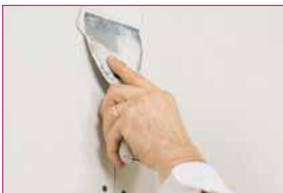
Emasse generosamente o rebaixo entre as placas (1ª camada de colagem da fita).
