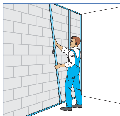
Colocação dos perfis
